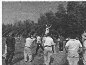
自力施工講習会
