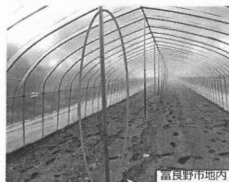
中柱の追加による 農業用ハウスの補強
